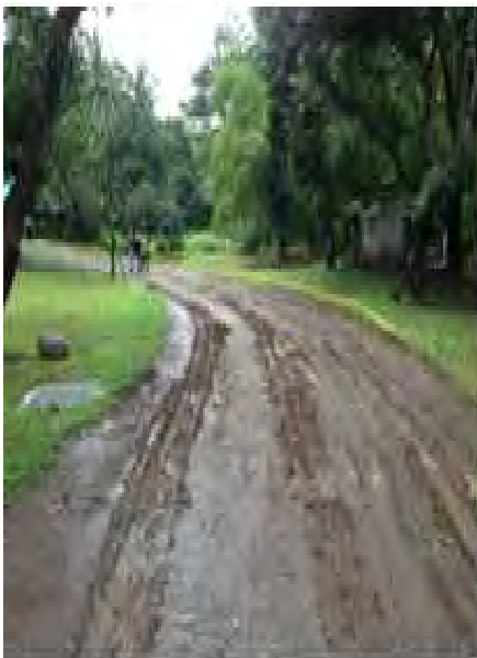
CAMINO NATURAL ESTABILIZADO
